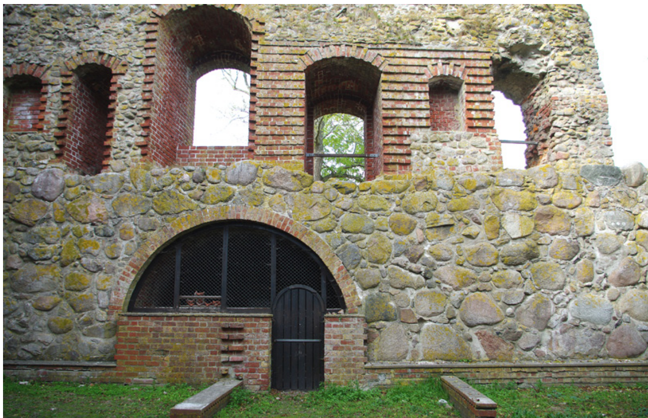
Västra insidan av Månstorp. Här ses tydligt den släta stenvägg och nedre det tunna tegelskal som högre upp bar upp ett tunnvalv som tak över rummet.
